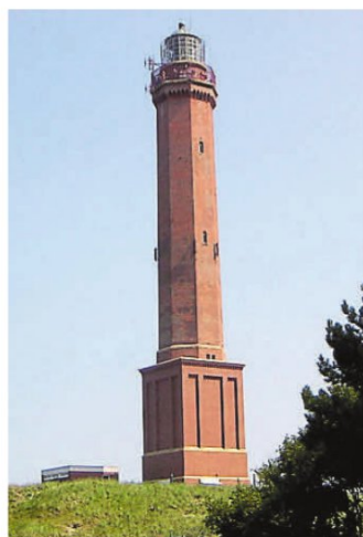
Der Leuchtturm auf Norderney wurde 1871 erbaut und zählt zu den drei wichtigsten Leuchttürmen in der Deutschen Bucht.
